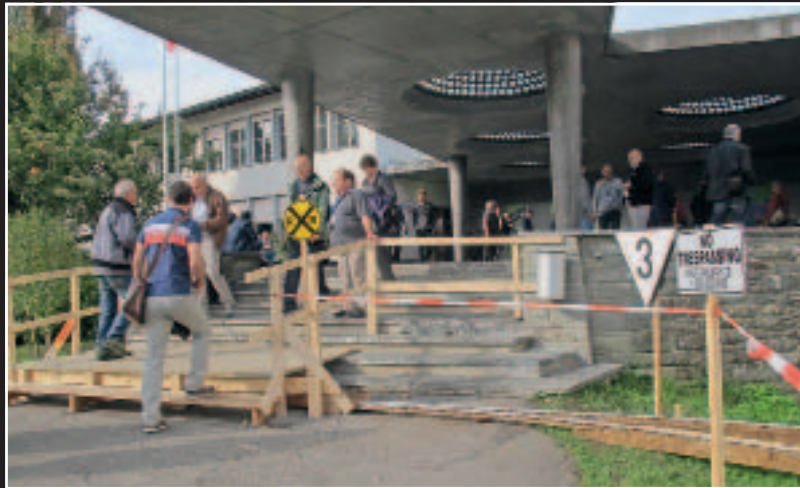
Für die Anlage der Am-Trackers musste eine Personenüberführung gebaut werden.
