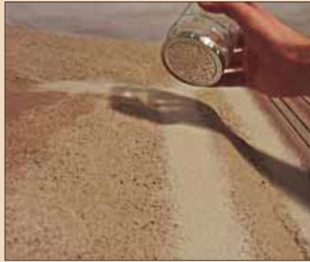
Mit feinem Sand wird als erstes ein ebener Untergrund geschaffen.
