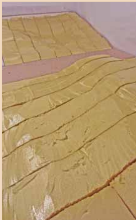
Element um Element wird aneinandergereiht. Anschließend werden die Fugen zugespachtelt.
