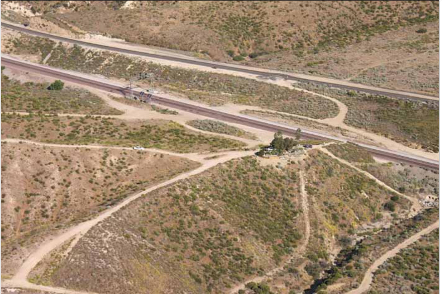
Luftaufnahme des Hill 582 mit dem UP-Gleis und den BNSF-Gleisen 1 und 2 (Aufnahme vom 2. Juni 2010).
